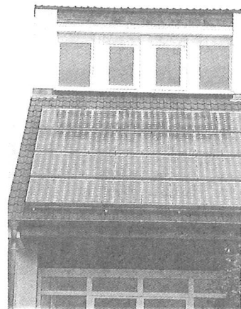
写真 16 屋根に設置されたソーラーパネル (フラウンホーファー研究所の「パンフレット」より)
