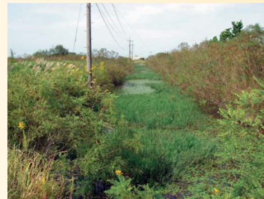
水路の通水阻害、ポンプ場の目詰まり
