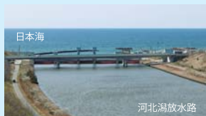
河北潟放水路 道の駅内灘から見た河北潟放水路。能登里山海道、防潮水門があり、その向こうは日本海。河北潟干拓地が作られた時に、湖の洪水対策として、内灘砂丘を掘削して作られました。
