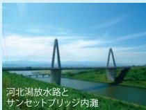
河北潟放水路とサンセットブリッジ内灘
