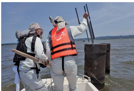
定期観測の様子（自動計測機の設置）
