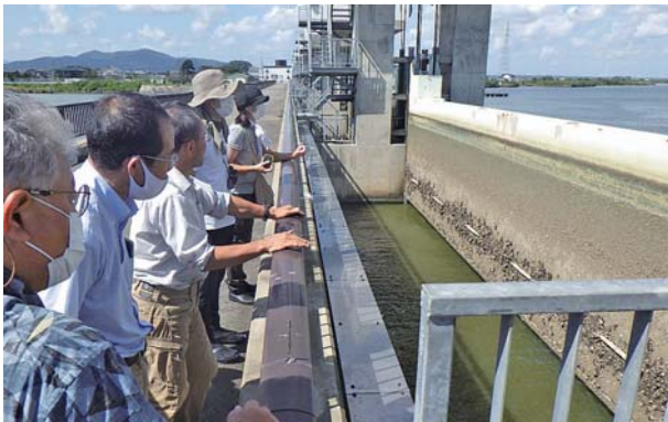
2007年に新設された防潮水門
