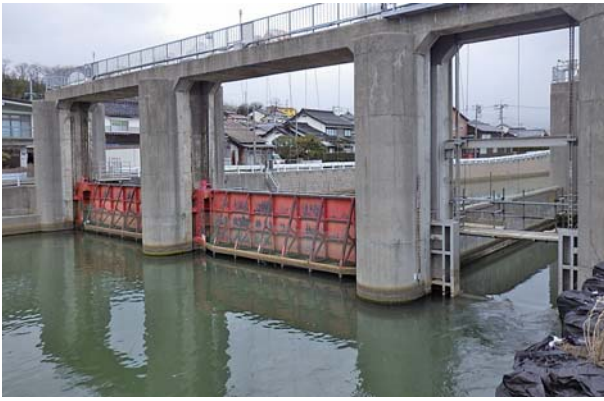
湖山川の防潮水門。切り欠きから海水が越流する。
