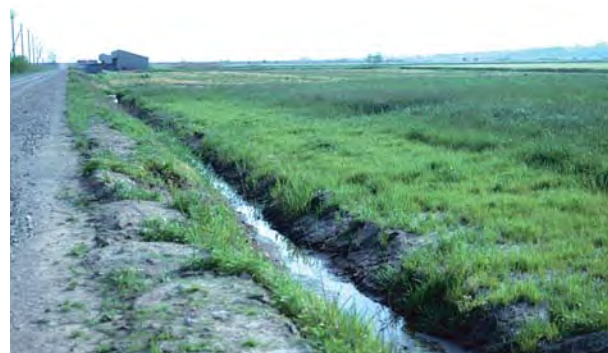
道路も側溝も未舗装・素掘りのままだった時代の干拓地
