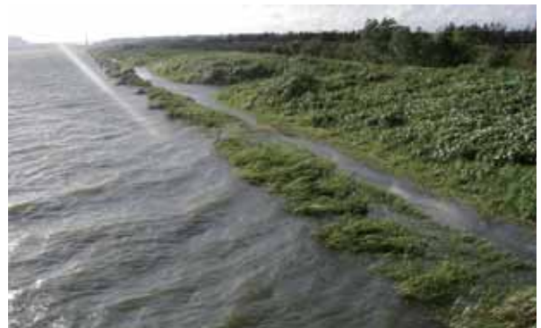
2010年9月13日。蛇籠が水没し、暴風時は浸水する。
