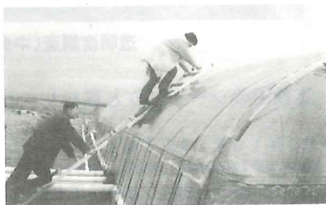
11月24日 屋根の補修
