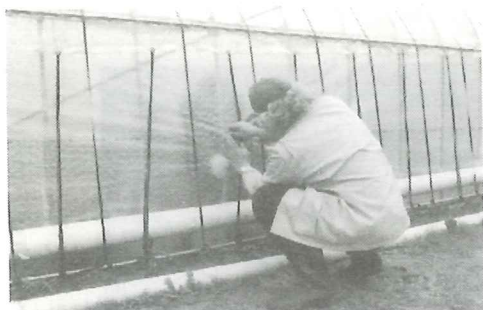
ビニルハウスの補修
